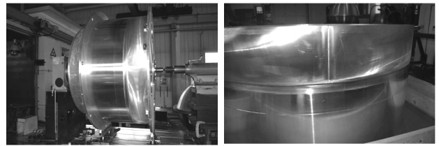
图 2 过渡环与箱筒段电子束焊接
