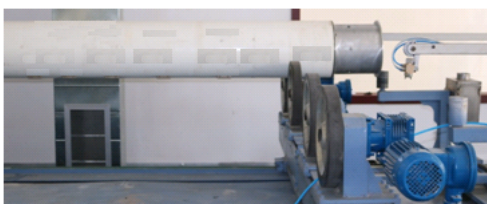
图7 壳体定位 Fig. 7 Shell fixed position
