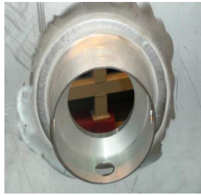
(b) 法兰焊缝正面
